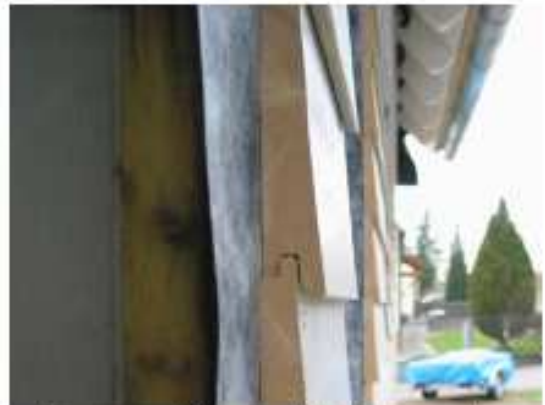
Isolierung und Hausverkleidung wurde 2002 angebracht
