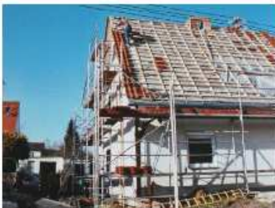
Aufdachisolierung und Dacheindeckung Creaton Harmonie
