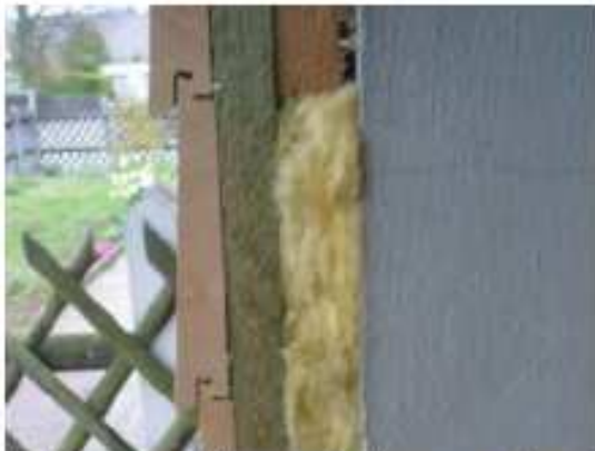
Isolierung und Hausverkleidung wurde 2002 angebracht
